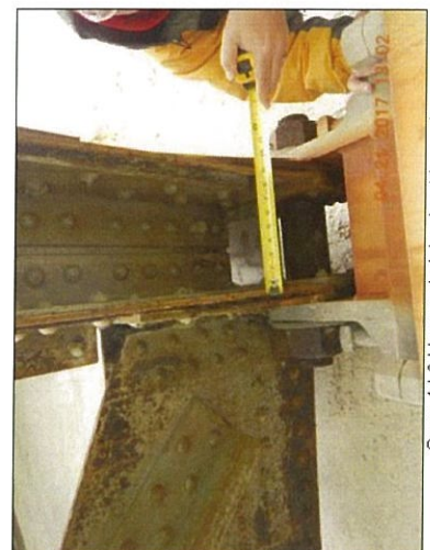
Span 1 L0 Lt gusset plates bent inward
